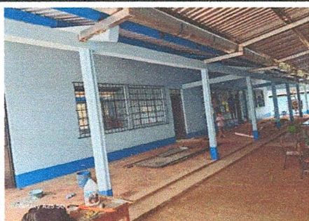
Foto 3: ENTECHADO DEL CORREDOR DEL MODULO 1
