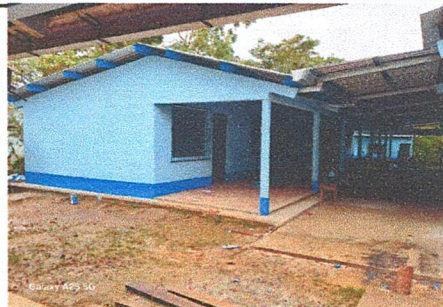
Foto 2: MANTENIMIENTO DEL MODULO 1
