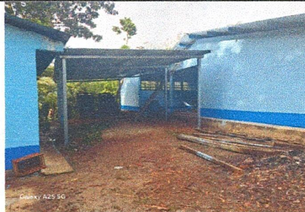
Foto 4: ENTECHADO DE DOS TINACOS
